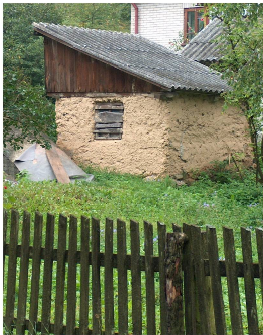
Przykład wykorzystania słomy oklejonej gliną do konstrukcji ścian budynku gospodarczego
