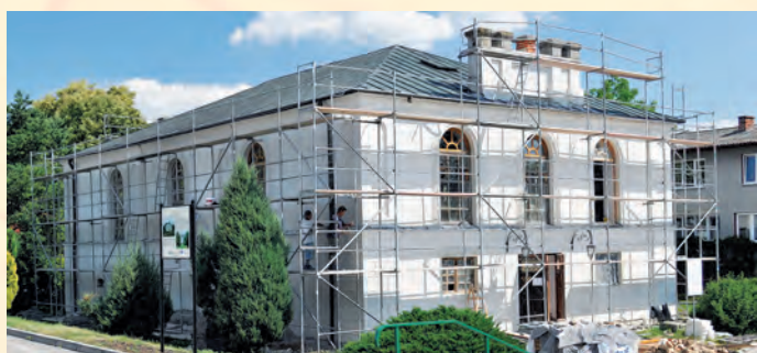
Remont zabytkowej synagogi w Wojsławicach
