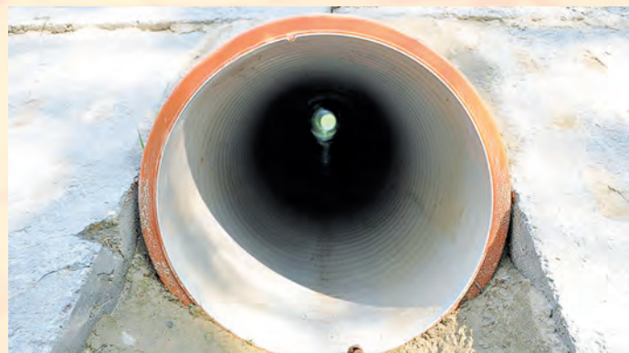
Przepust w Majdanie Ostrowskim
