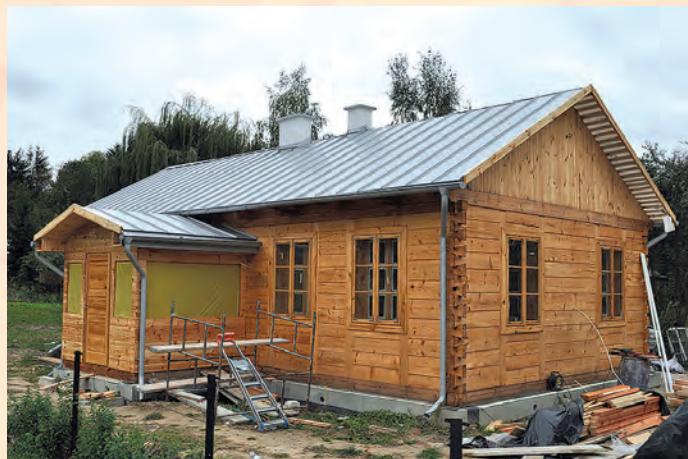
Remont dawnej szkoły w Rozięcinie
