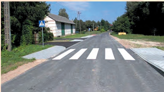
Przebudowana droga w Starym Majdanie
